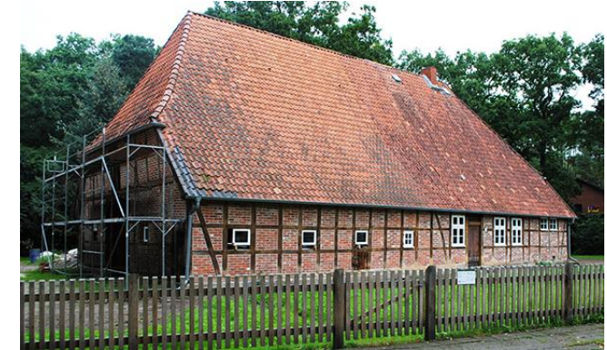
Sanierung Zweistöcker-Fachwerkhäuser in Krelingen bei Walsrode
