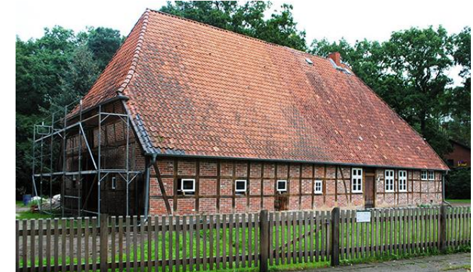
Sanierung Zweistöcker-Fachwerkhäuschen in Krelingen bei Walsrode
