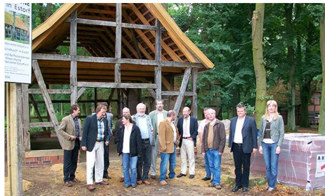
Bau der Tabakscheune Scheunenviertel Estorf 2008
