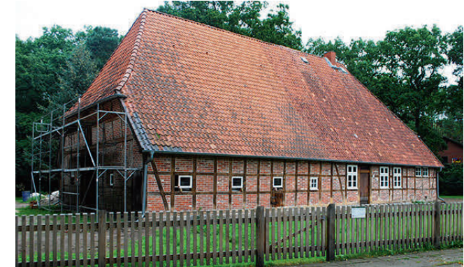
Sanierung Zweistöcker-Fachwerkhäuser in Krelingen bei Walsrode
