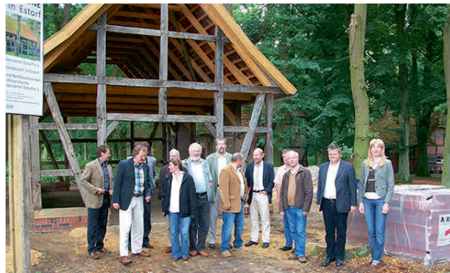
Bau der Tabakscheune Scheunenviertel Estorf 2008
